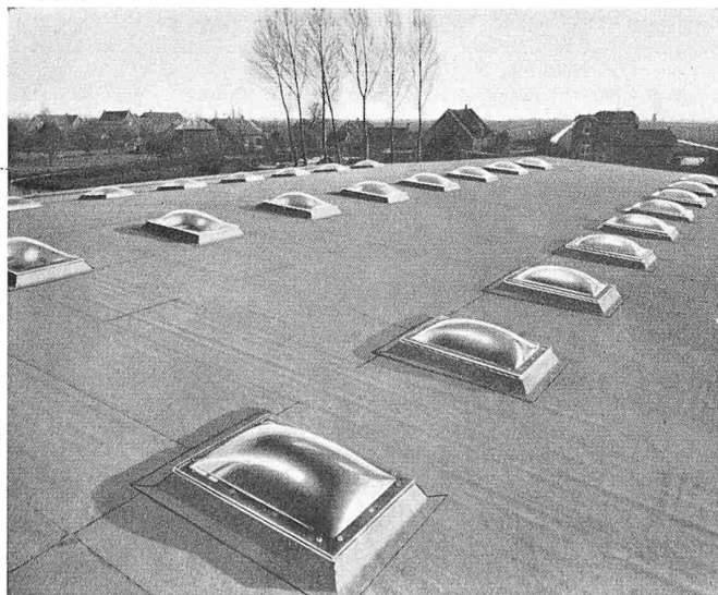
Dach mit viereckigen Cupolux-Oberlichtern
