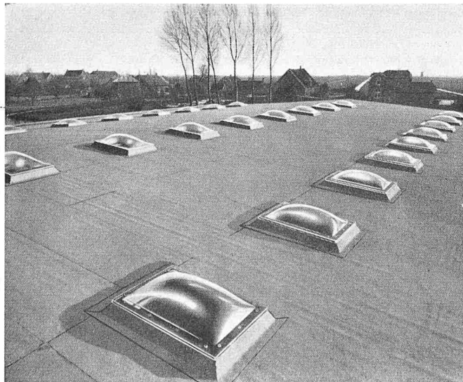
Dach mit viereckigen Cupolux-Oberlichtern
