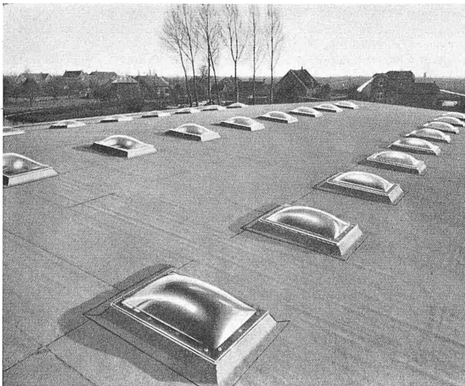
Dach mit viereckigen Cupolux-Oberlichtern
