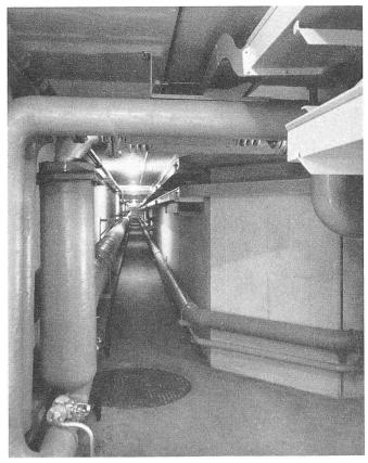
Bild 8. Begehbarer Leitungskanal
