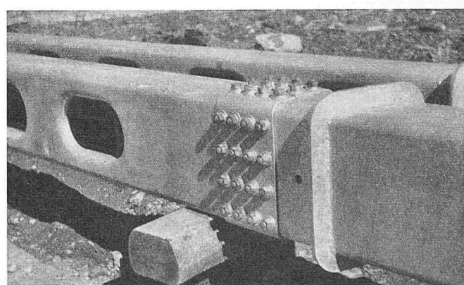
Fig. 2. Joint boulonné
