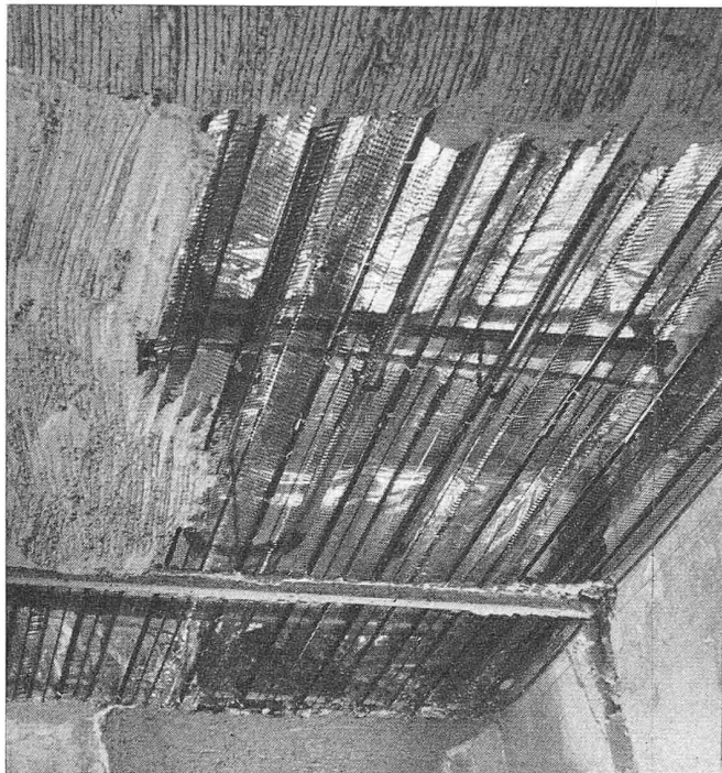
Bild 1. Hohlraum-Strahlungsheizung. Glasfasermattenisolierung mit Al-fol, Rohraufhängeschienen, Rohre, Streckmetallgipsdecke (Gebr. Sulzer, Winterthur)
