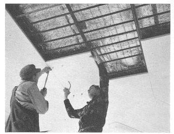
Bild 2. Hohlraumheizung mit Gipsplattendecke (Isolag, Zürich)
