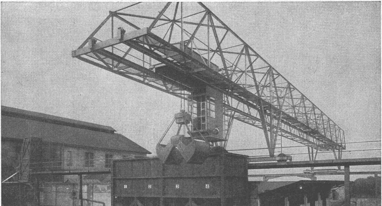
Verladebrücke in Schweisskonstruktion 2,5 t Tragkraft, 46 m Länge
