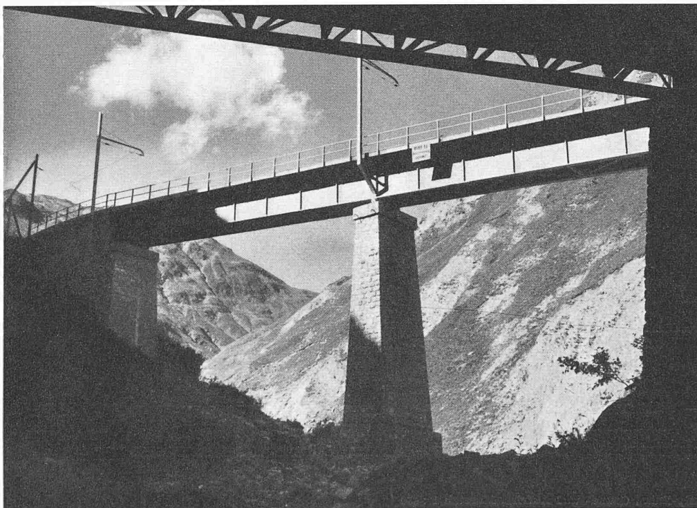
Bild 1. Fertige Brücke talaufwärts gesehen. Am oberen Bildrand ist noch ein Teil der Strassenbrücke sichtbar, über die der Umsteigeverkehr geleitet wurde.
