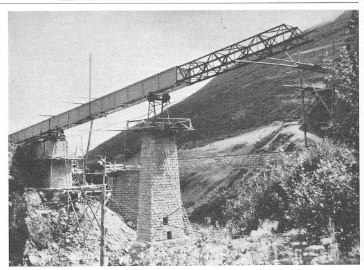
Bild 5. Links ist das untere Widerlager zu erkennen. Die Brücke ist hier bereits fertig zusammengebaut, der hintere Teil befindet sich noch auf der Verschiebebahn. Der Einbauschnabel reicht bald bis zum obern Widerlager, das am rechten Bildrand noch sichtbar ist.
