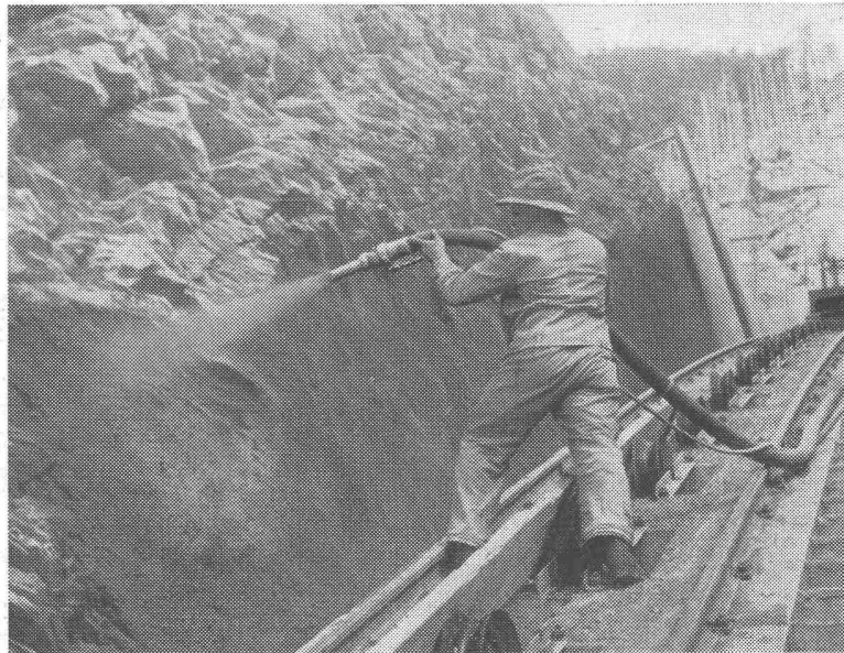
Felskonsolidierung bei der Druckleitung des Kraftwerkes Mauvoisin
