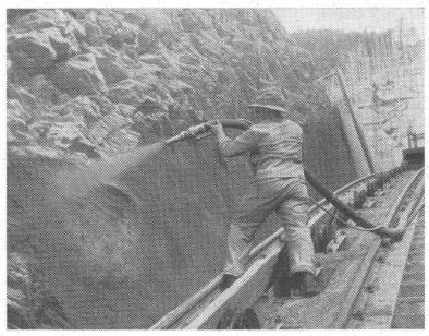
Felskonsolidierung bei der Druckleitung des Kraftwerkes Mauvoisin
