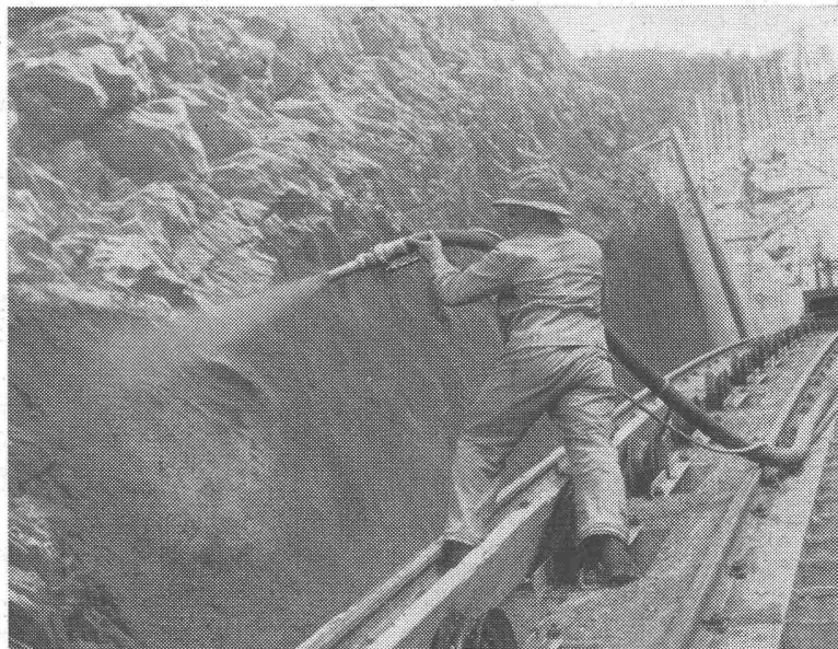
Felskonsolidierung bei der Druckleitung des Kraftwerkes Mauvoisin
