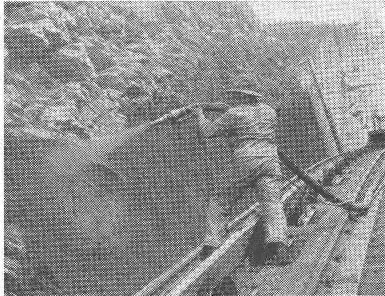
Felskonsolidierung bei der Druckleitung des Kraftwerkes Mauvoisin
