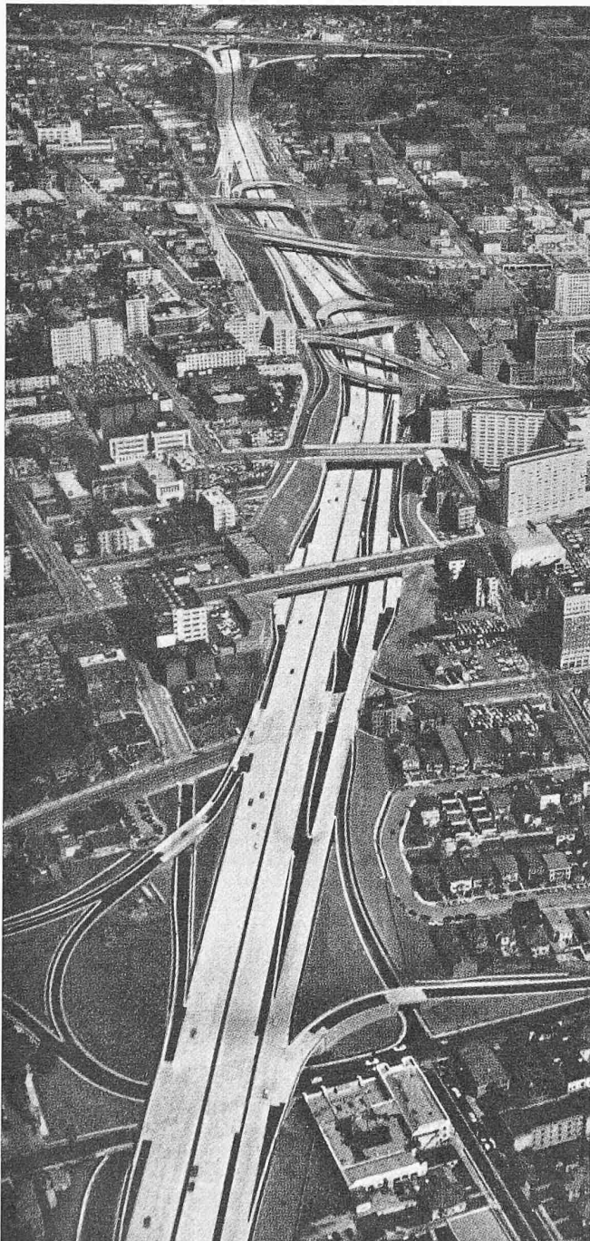
Der Downtown-Abschnitt der neuen Ausfallstrasse von Los Angeles
