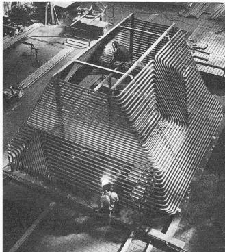
Bild 41. Unterer Teil einer Brennkammer (umgekehrt)
