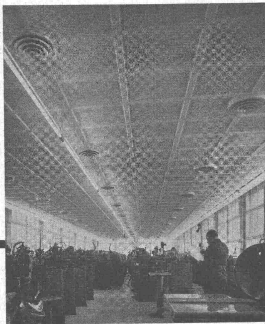
Klimaanlage «System Häusler» in Uhrenfabrik
