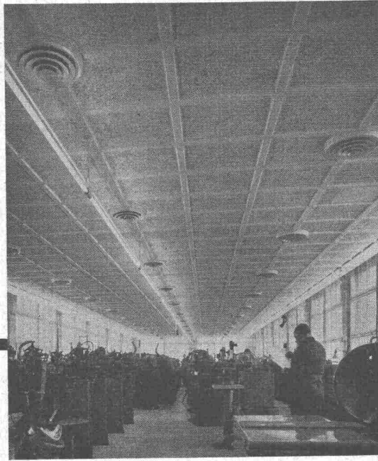
Klimaanlage «System Häusler» in Uhrenfabrik
