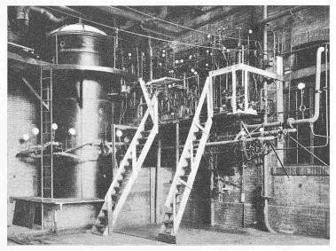
Bild 11. Erste Versuchsanlage für Einrohr-Dampferzeuger aus dem Jahre 1929
