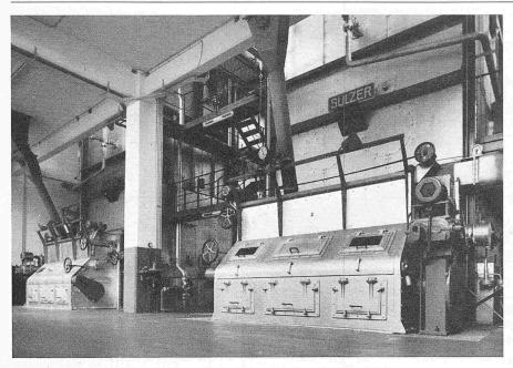
Bild 5. Heizerstand einer Strahlungs-Kesselanlage in einer Cellulosefabrik
