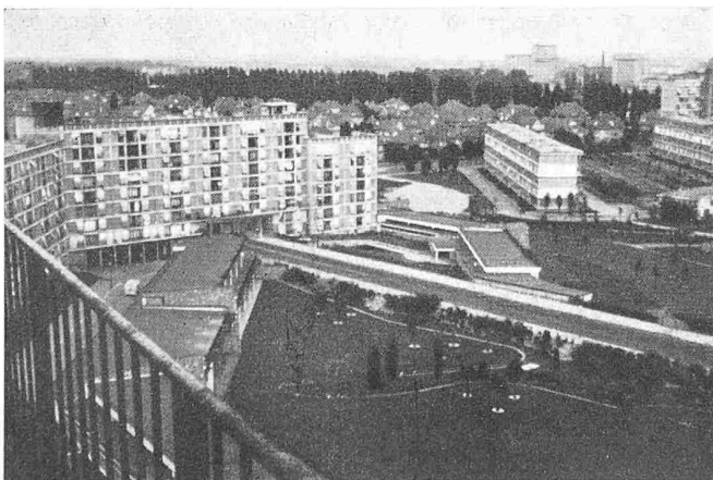
Die Cité Rotterdam in Strassburg besteht aus sehr grossen Baukörpern, ausser Spielplätzen und gepflegten Gärten Schulhäuser und Kindergärten
