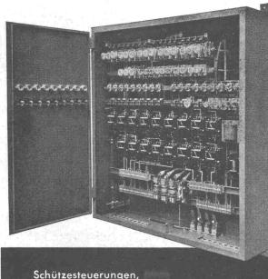
Unsere Verteilkasten und -schränke werden für Aufbau- oder Unterputzmontage, auch staub- und spritzwasserdicht, in jeder beliebigen Ausführung und Grösse geliefert. Die Innenausrüstung ist praktisch, mit genügend Montageraum, das Aeussere von zweckmässiger Schönheit. Die Apparate werden fertig eingebaut und verdrahtet; der Apparaterost lässt sich zur Montage einfach herausheben. Gute Erweiterungsmöglichkeit. Verlangen Sie bitte unsere Prospekte.
