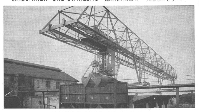
Verladebrücke in Schweisskonstruktion 2,5 t Tragkraft, 46 m Länge
