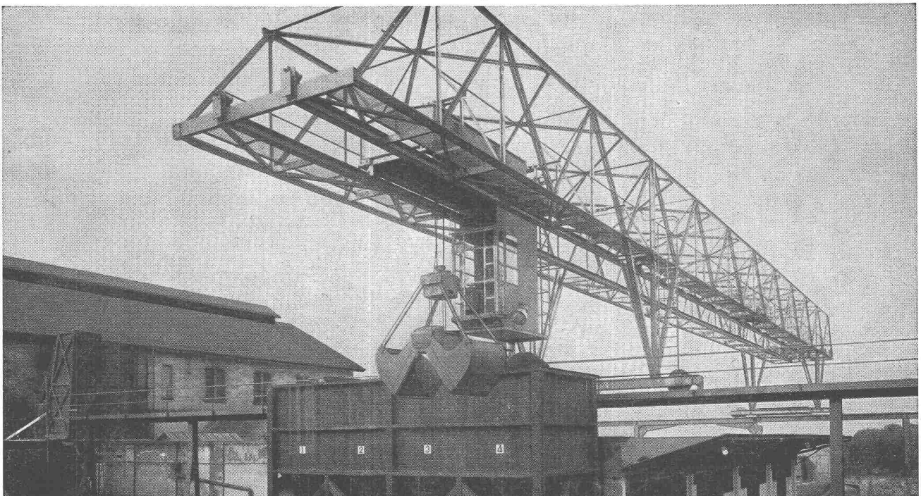
Verladebrücke in Schweisskonstruktion 2,5 t Tragkraft, 46 m Länge
