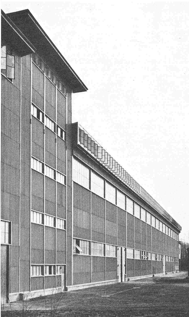
Bild 4. Ansicht der Nordfassade aus Osten
