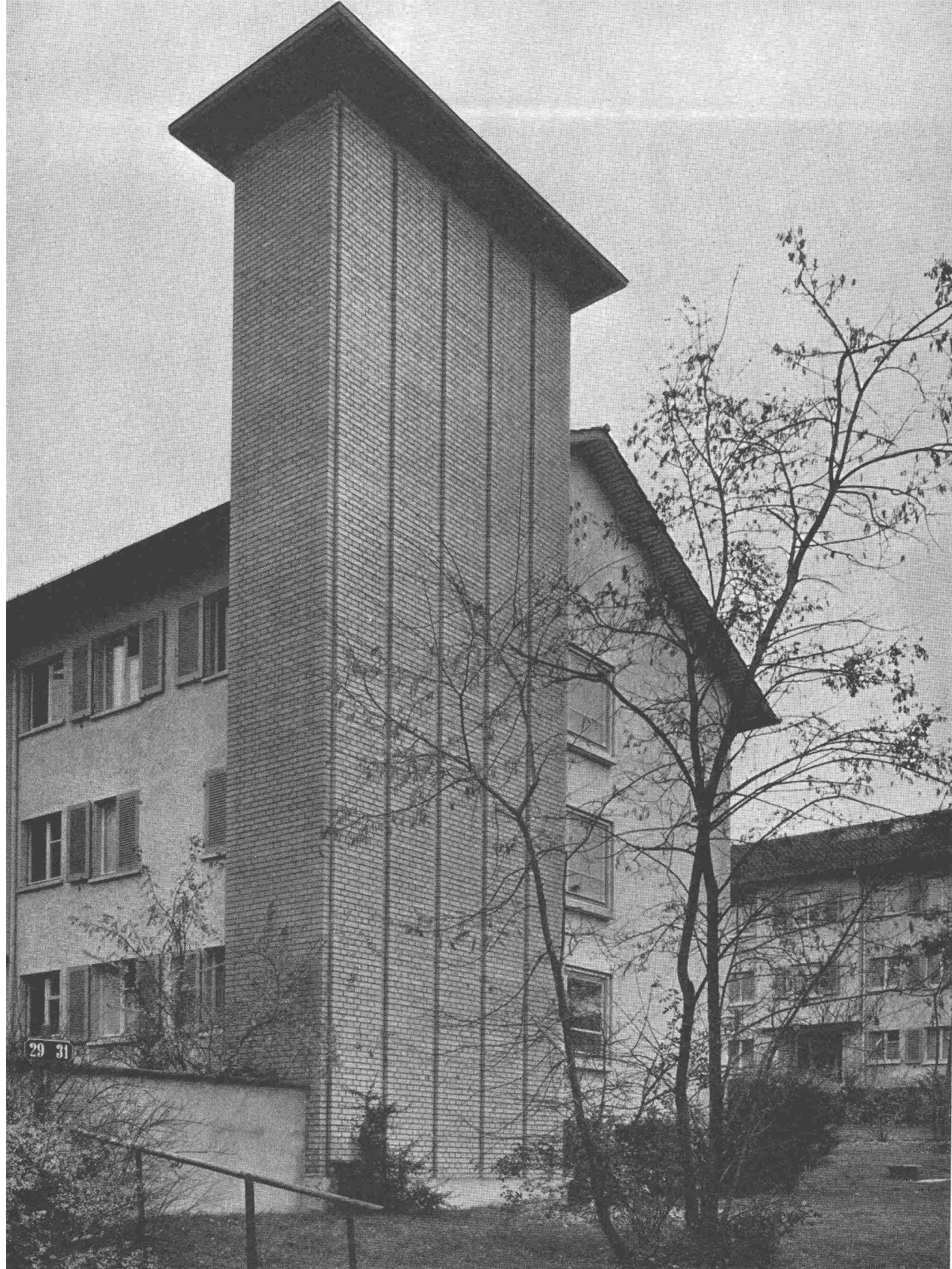
5-Züger Kamin einer Heiz- und Warmwasserzentrale
