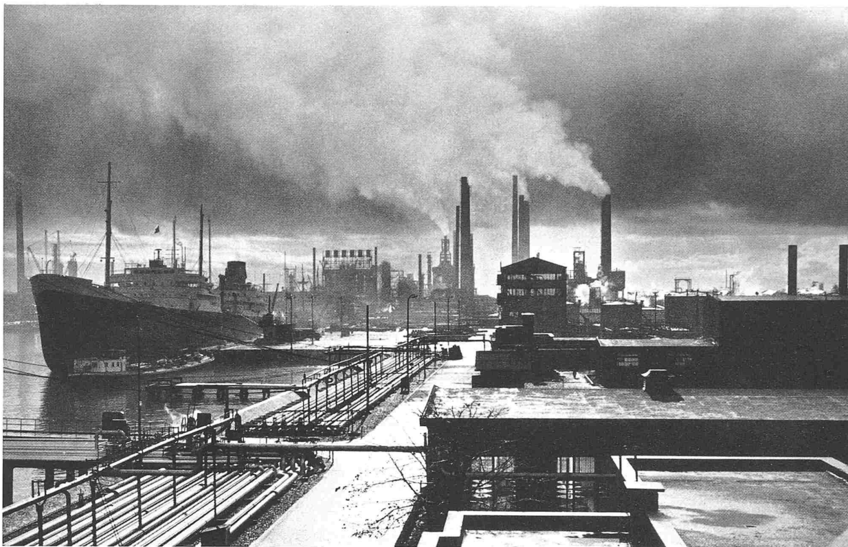
Shell Installaties en Fabrieken in Pernis bei Rotterdam. Tanker löschen das Erdöl, das in der Raffinerie der Shell-Anlagen zu Fertigprodukten verarbeitet wird. Links ein Teil der Petroleumhäfen. Rechts die Büros, im Hintergrund die Dubbs-Krackanlage. Unten einer der Petroleumhäfen von Pernis. (Shellphoto)
