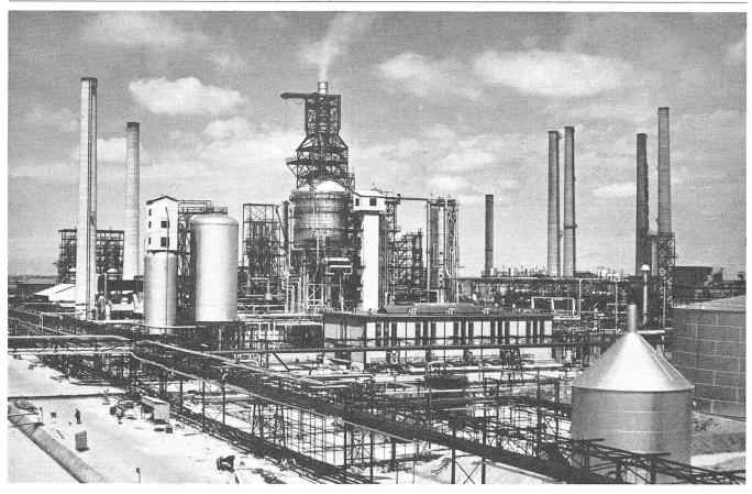
Shell installaties en fabrieken «Pernis», Rotterdam. Uebersicht über einen Teil der katalytischen Krackanlage. Von links nach rechts: Der Kamin des Ofens (60 m hoch); Katalysatortrichter; oben die Katalysatorförderanlage. Im Vordergrund das Kompressorenhaus, dahinter der Regenerator mit Fahrschacht und (wenig sichtbar) der Reaktor. Im Hintergrund rechts die Fraktionierkolonne
