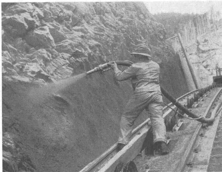
Felskonsolidierung bei der Druckleitung des Kraftwerkes Mauvoisin
