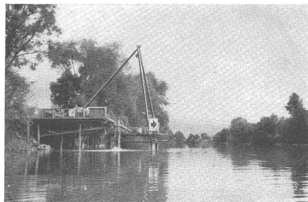
Düker zur Unterfahrung des Zihlkanals
