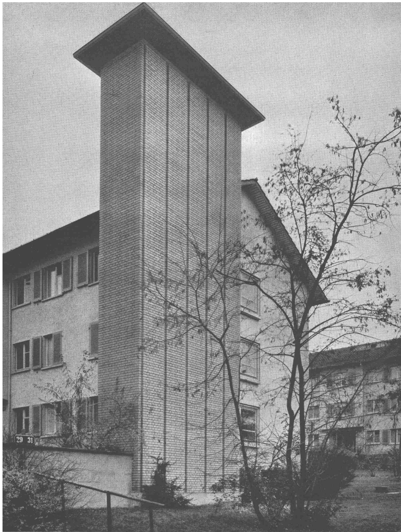
5-Züger Kamin einer Heiz- und Warmwasserzentrale
