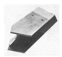
Bild 10. Detail eines Trägerendes beim Anschluss an den First. Dieser Trägerschnitt zeigt, dass trotz der einfachen Gesamtkonzeption im Detail komplizierte Anschlüsse ausgeführt werden mussten
