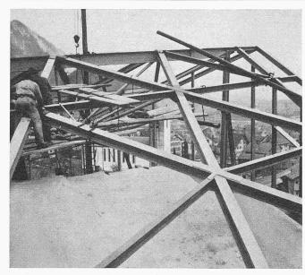
Bild 4. Dachaufsicht nach Verschweissen der Knotenpunkte. Die obern Stosslaschen sind schmäler, die untern breiter als die Trägerflansche, so dass sämtliche Montageschweissnähte von oben ausgeführt werden konnten
