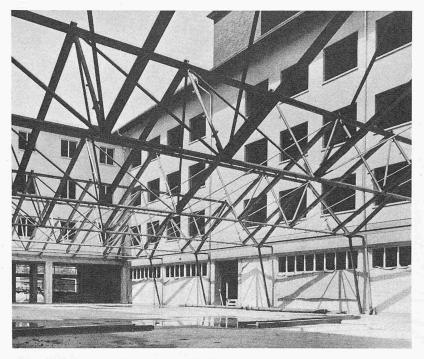
Bild 4. Selbsttragende Sheds für eine Hofüberdachung
