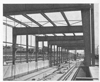
Bild 3. Neubau Schindler & Cie. in Ebikon, Windverband in Rohrbau
