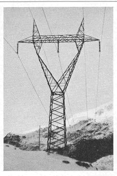
Bild 5. Y-Mast der 225-kV-Leitung Löbbia-
