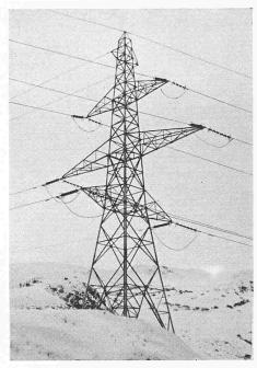
Bild 6. Sammelmast zweier 225-kV-Leitungen bei Bivio
