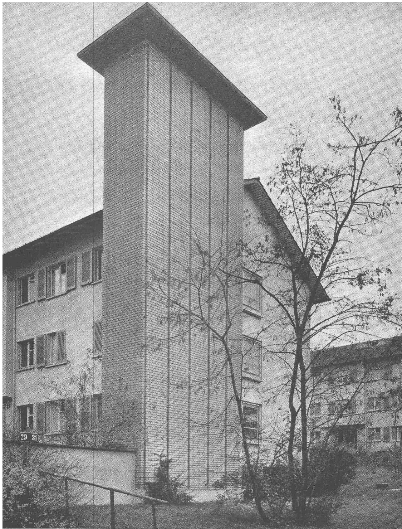
5-Züger Kamin einer Heiz- und Warmwasserzentrale
