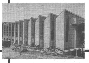
Eisenbetonbau, vollständig mit PORA-Platten ummantelt
