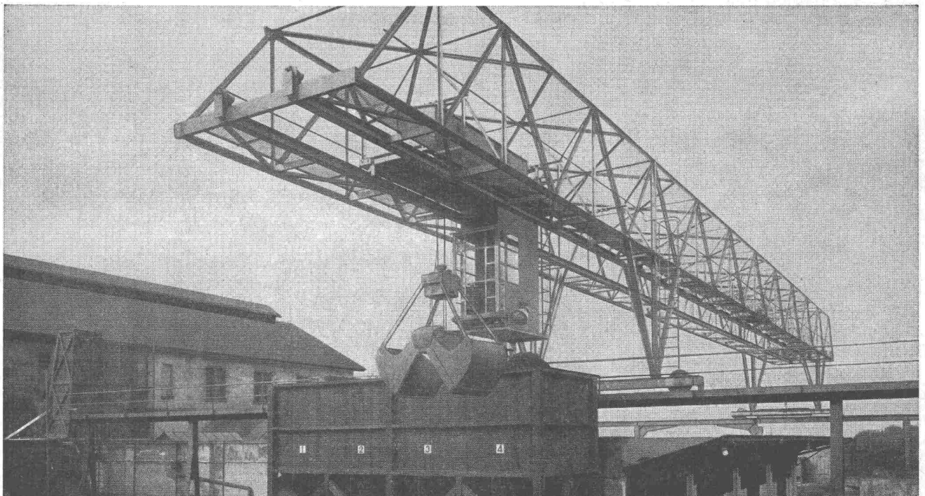
Verladebrücke in Schweisskonstruktion 2,5 t Tragkraft, 46 m Länge
