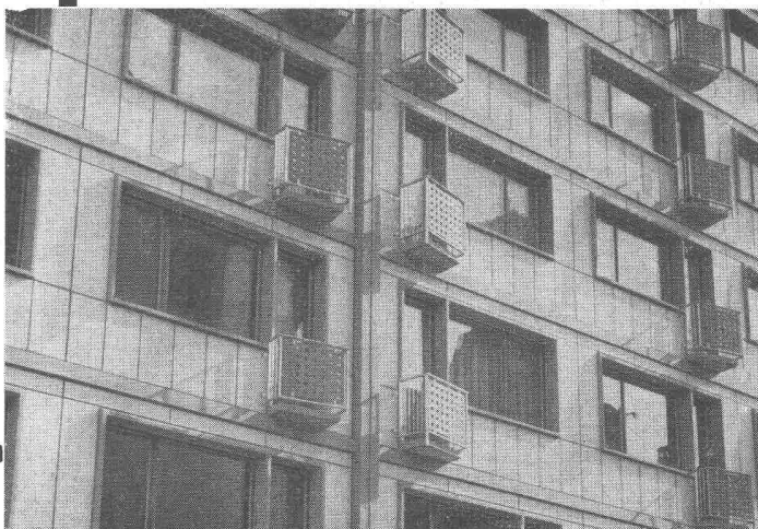
Ausfuchung eines Beton-Skelettbaues
