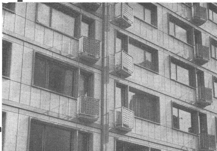
Ausföchung eines Beton-Skelettbau
