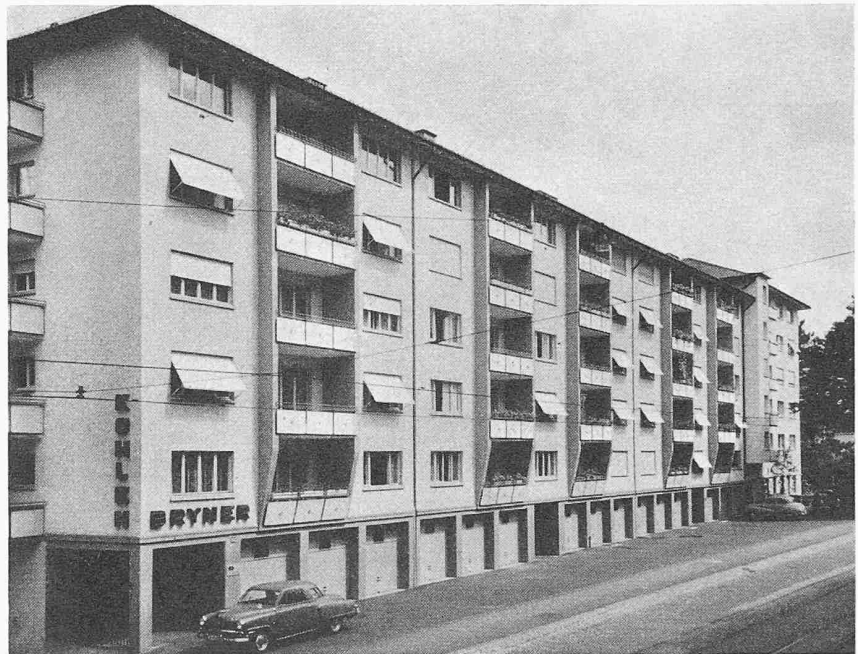
Westfassade an der Seestrasse
