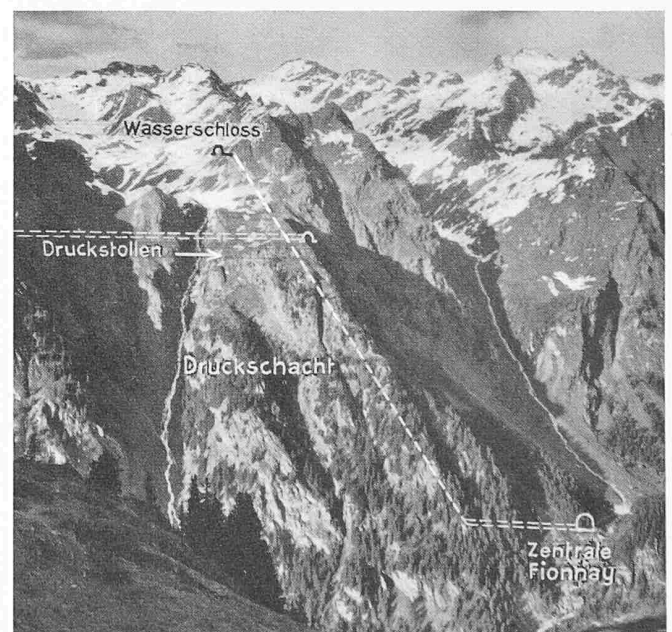
Bild 2. Val de Bagnes, mit Eintragung von Wasserschloss und Zentrale der Grande Dixence SA.
