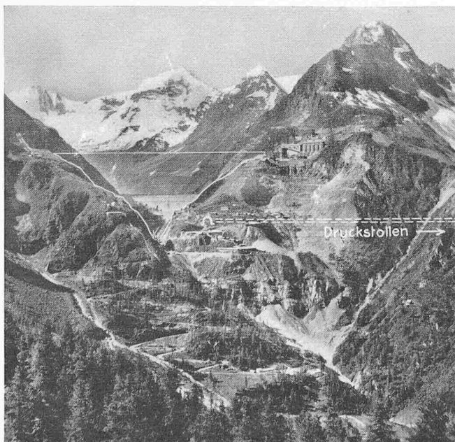
Bild 1. Val des Dix, links die bestehende Staumauer, davor eingetragt das Profil der im Bau begriffenen Mauer von 285 m Höhe
