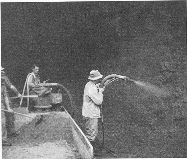
Bild 1. Spritzbetongruppe an der Arbeit
