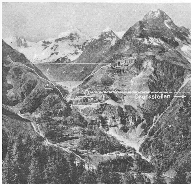
Bild 1. Val des Dix, links die bestehende Staumauer, davor eingetragenes Profil der im Bau begriffenen Mauer von 285 m Höhe
