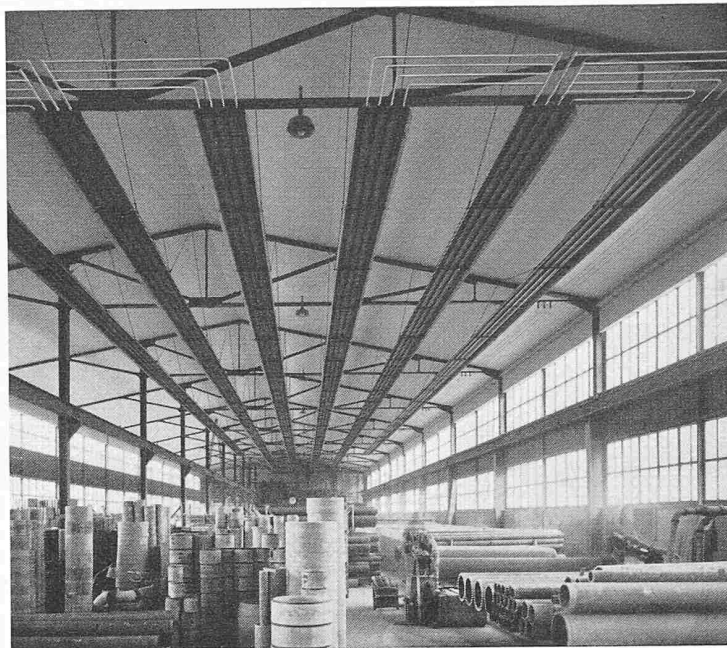
Bild 5. Bandstrahler in der neuen Röhrenfabrik der Eternit AG, Niederurnen
