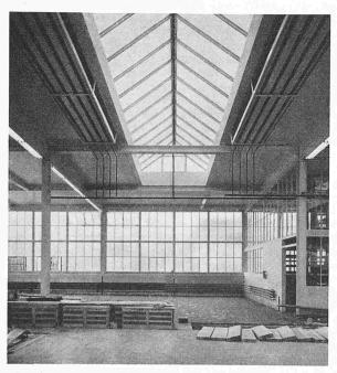
$\begin{tabular}{ll} \bf Bild~1. & \bf Werkhalle~mit~Hochtemperatur-Strahlungsheizung~in \\ \bf Form~von~Bandstrahlern \\ \end{tabular}$
