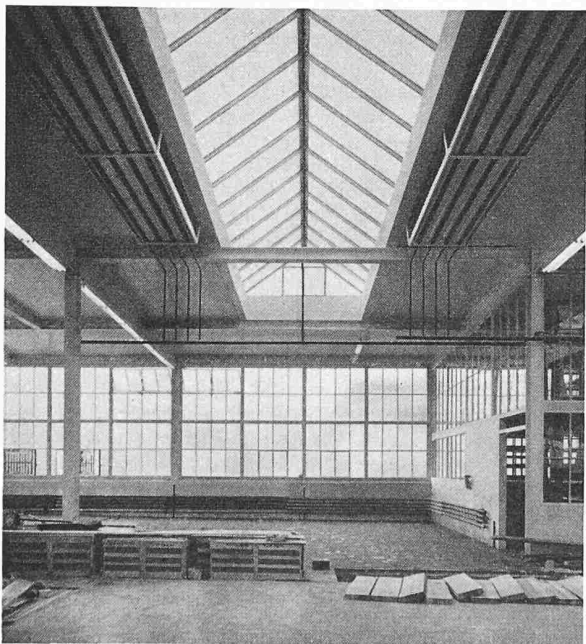
Bild 1. Werkhalle mit Hochtemperatur-Strahlungsheizung in Form von Bandstrahlern
