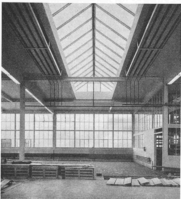
Bild 1. Werkhalle mit Hochtemperatur-Strahlungsheizung in Form von Bandstrahlern
