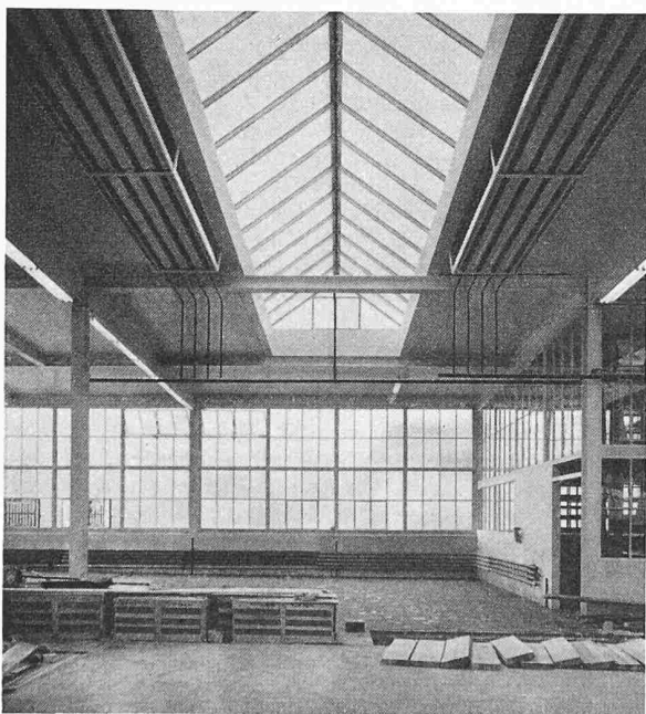
Bild 1. Werkhalle mit Hochtemperatur-Strahlungsheizung in Form von Bandstrahlern
