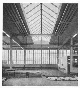
Bild 1. Werkhalle mit Hochtemperatur-Strahlungsheizung in Form von Bandstrahlern
