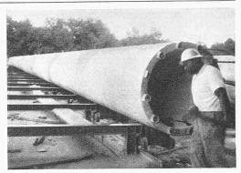
Bild 13. Vorgespannter, 25 m langer Pfahl
