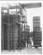
Bild 12. Betonrohr nach Verlassen der Dampfkammer
