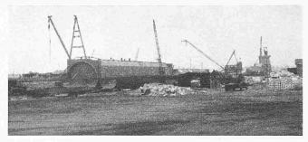
Bild 7. Schwimmkasten im Dock
