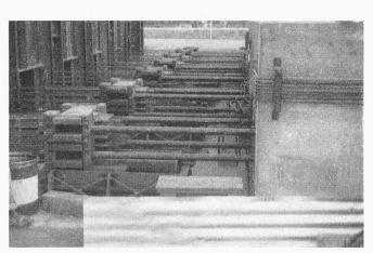
Bild 14. Herstellung der Brückenfahrbahn im Spannbett, Vorspannung der Längsträgerdrähte. Links dampfdichte Form, rechts Ankerblöcke
