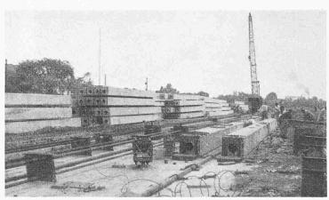
Bilder 4 und 5. Herstellung der vorgespannten, rd. 9 m langen Pfähle im Spannbett. Die Pfähle, in Vierergruppen eingerammt, bilden die Pfeiler der Brücke
