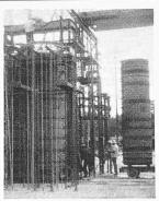
Bild 12. Betonrohr nach Verlassen der Dampfkammer
