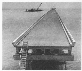
Bild 15. Die Lake Pontchartrain-Brücke vom Ufer aus, im Hintergrund der Schwimmkran zum Versetzen der Fahrbahntafeln
