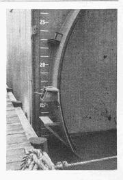
Bild 10. Einzelheiten der Kupplung: Ueberlappungsstreifen, seitl. Leitschiene für das Abschlussblech, untere Hälfte des Verbindungsgelenks. Podest für den Taucher
