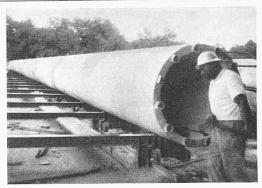
Bild 13. Vorgespannter, 25 m langer Pfahl
