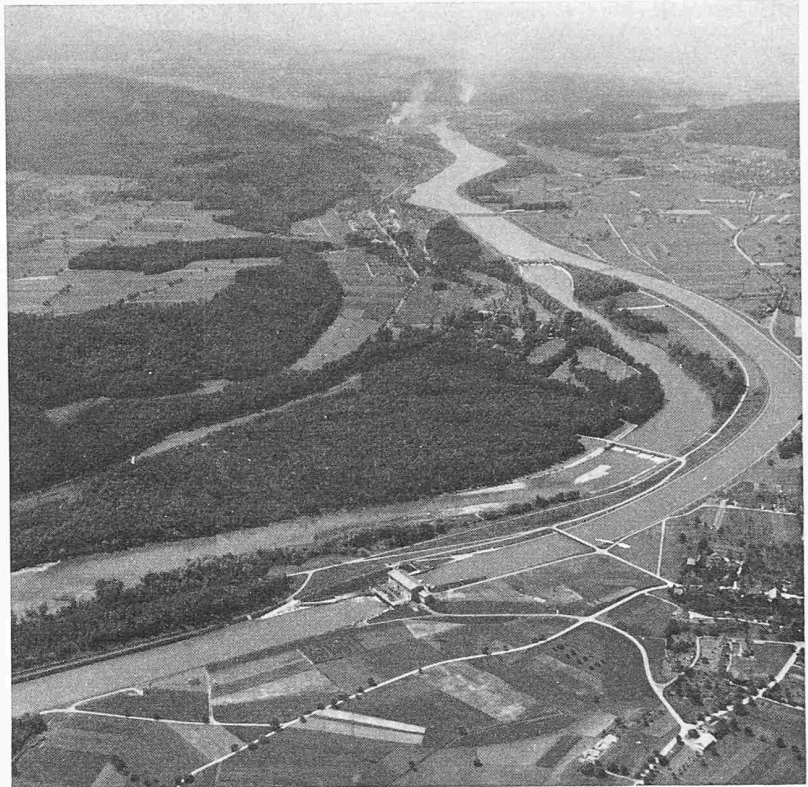
Bild 77. Fliegerbild des Kraftwerkes Wildegg-Brugg. 1. Juli 1955
