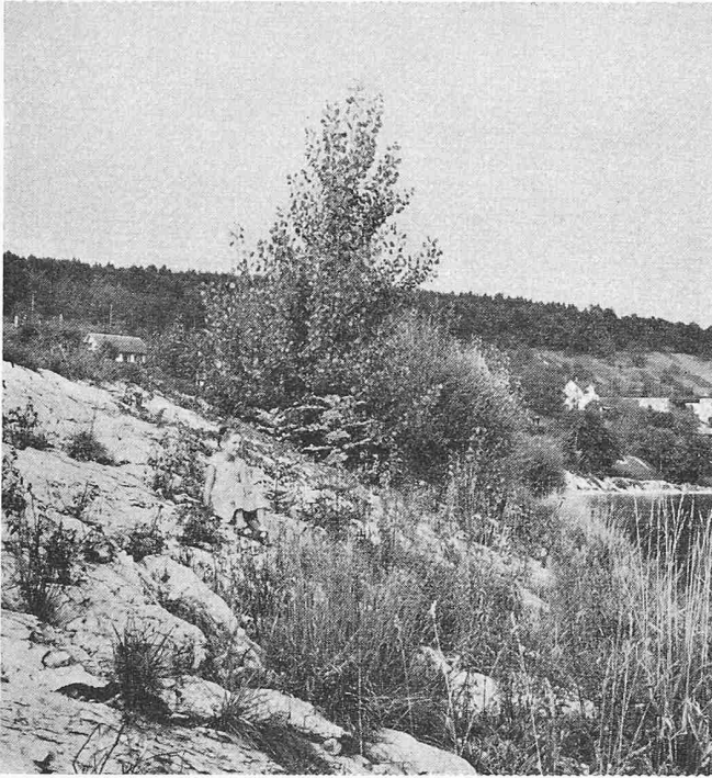
Bild 74. Bewuchs der Böschungspflasterung an der Mündung des Unterwasserkanales durch Samenflug. 23. September 1955
