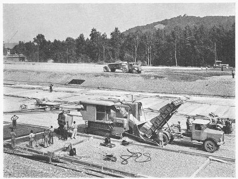
Bild 66. Oberwasserkanal. Betonieren der Sohlenplatten. 23. August 1950
