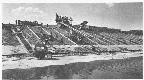
Bild 67. Oberwasserkanal, Betonieren der Böschungsplatten. 2. Mai 1951
