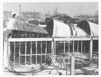
Bild 3. Oberflächenbehandlung von Betongewölben mit VC-Matten, Ausschalfrist 2 Tage (Bordeaux, Frankreich)
