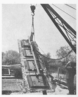
Bild 2. Spannungsfreier Transport von Bitumen-Betonplatten mit Hilfe eines Vacuum-Lifters
