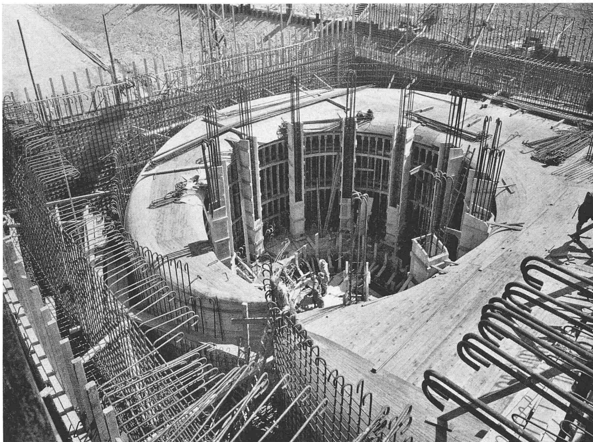
Bild 62. Maschinenhaus. Schalung der Einlaufspirale für Maschinengruppe 2. 23. August 1950
