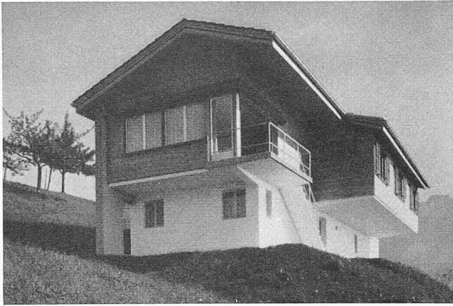
Ansicht aus Südwesten
