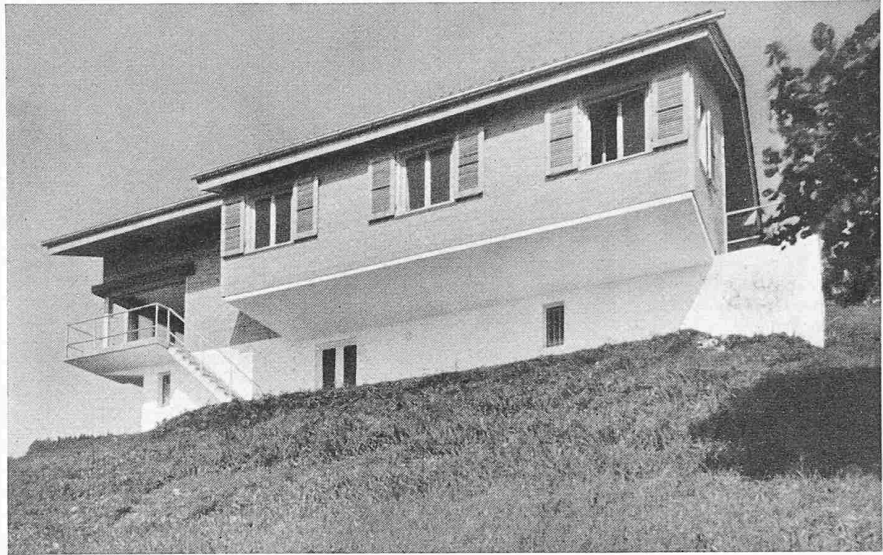
Ansicht aus Süden
