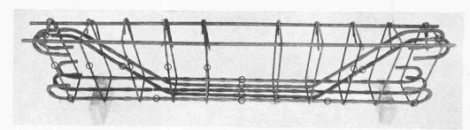
Bild 4a. Armierungsgerüst der Balken. Typ A (Trajektorienarmierung)
