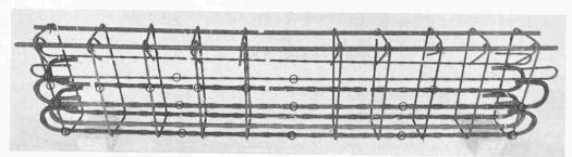
Bild 4b. Armierungsgerüst der Balken. Typ B (Orthogonalarmierung)
