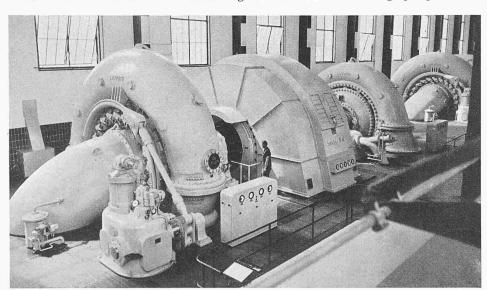
Bild 12. Maschinensatz im Speicherwerk Waldshut. Von links nach rechts: Turbine mit Regulator, Generator-Motor, Freistrahl-Anwurfturbine, Pumpe
