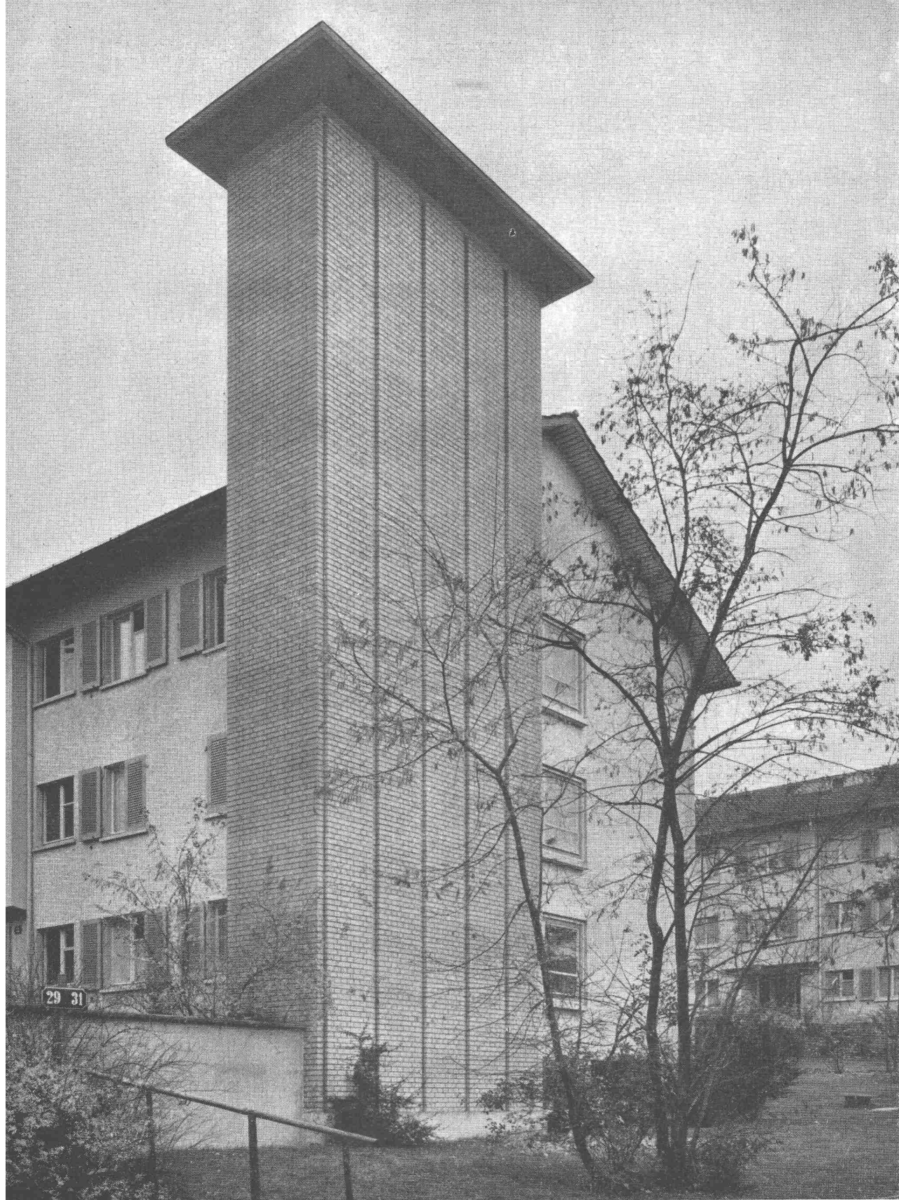
5-Züger Kamin einer Heiz- und Warmwasserzentrale
