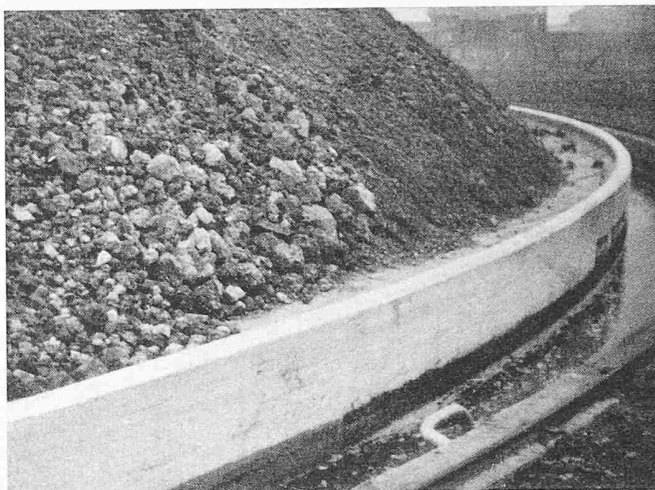
Bild 15. Grobes und feines Tropfkörpermaterial wahllos aufgeschüttet
