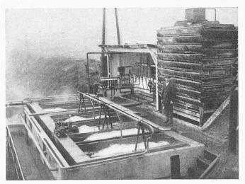
Bild 13. Anlage zum biologischen Phenolabbau (Emscherfilter)
