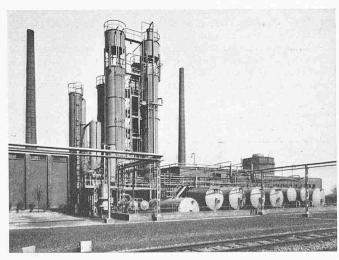
Bild 12. Entphenolungsanlage für Kokereiabwasser
