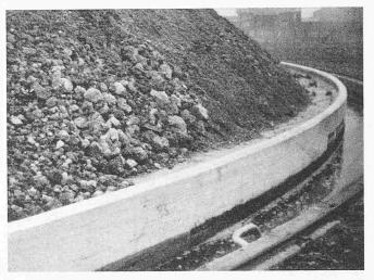
Bild 15. Grobes und feines Tropfkörpermaterial wahllos aufgeschüttet
