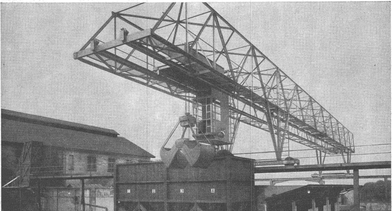
Verladebrücke in Schweisskonstruktion 2,5 t Tragkraft, 46 m Länge
