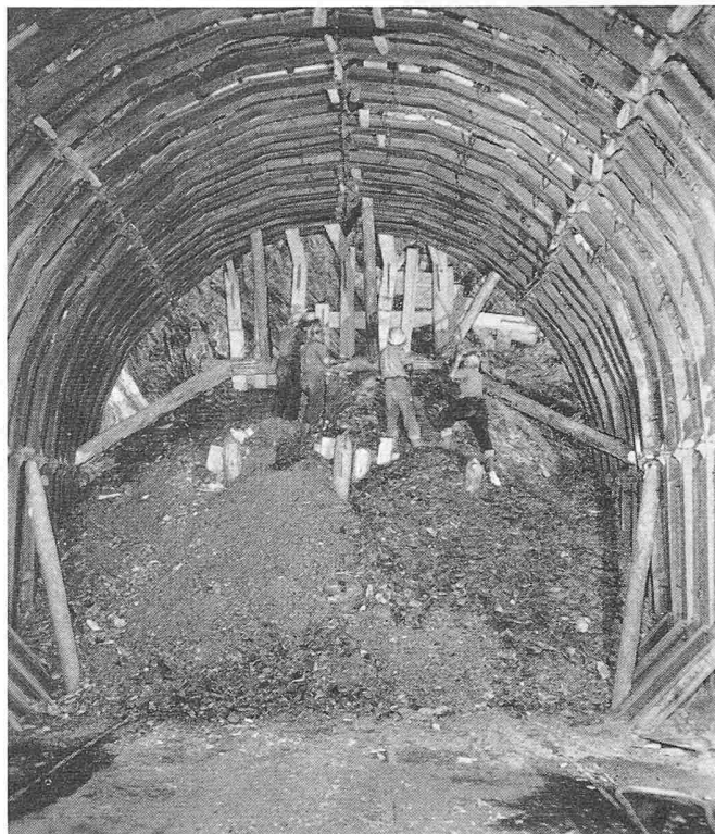
Bild 10. Vollausbuch in Mylonit; Westseite Km. 2,370
