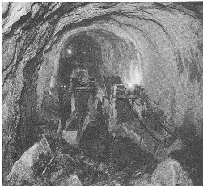
Bild 7. Die beiden vor Ort nebeneinander arbeitenden Conway-75-Bagger
