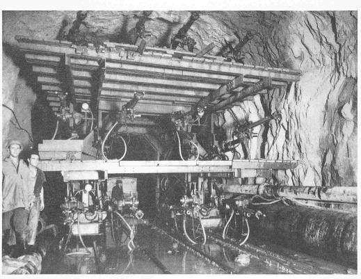
Bild 6. Bohrgestell mit zwölf DA-35-Hämmern (Ostseite)
