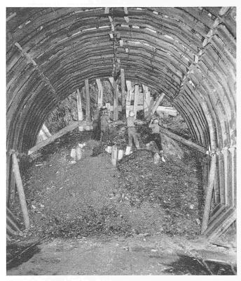
Bild 10. Vollausbruch in Mylonit; Westseite Km. 2,370
