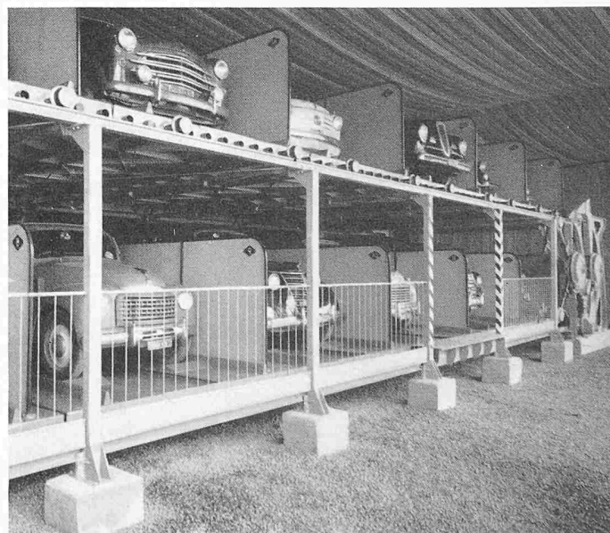
Bild 3. Untere und obere Boxenreihe sowie Mittelteil-Traggerüst mit Wagenentnahmeforte (Schiebebühne fehlt)
