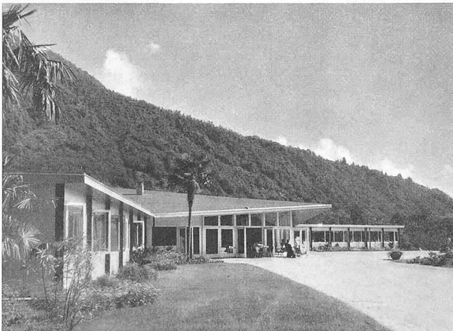
Bild 9. Teilansicht mit Halle
