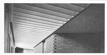
Bild 10. Detail der Gangdecke beim Anschluss an die Halle
