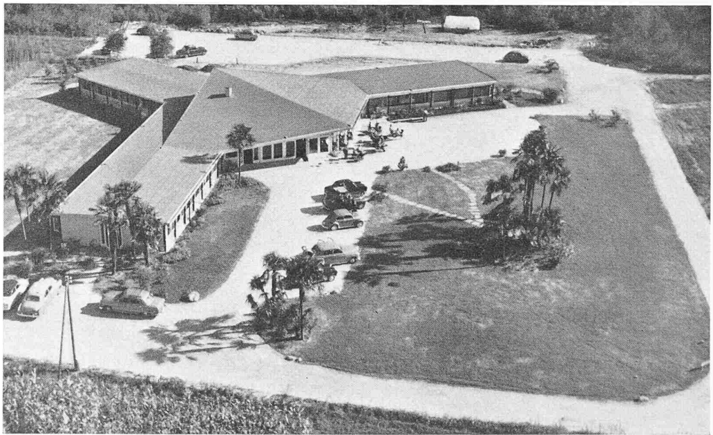
Bild 5. Fertiger Bau aus Südwesten
