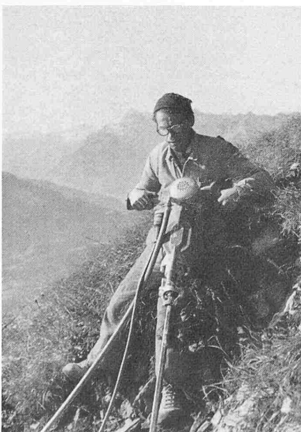
Bilder 2 und 3. Beim Bau von Lawinerverbauungen
