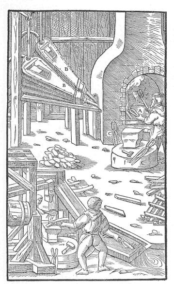
Bild 4. Frischfeuer, A Frischfeuer, B Blasebälge, C Zangen, D Hammer, E fliessendes Wasser
