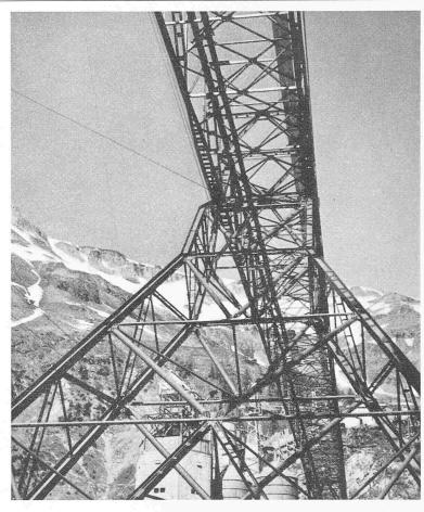
zusammengestellt werden, bis durch Senken der Hauptträger auf einer Presse am Kragarmende der Bühne (Knoten 14) der Bolzen im Untergurtknoten 13 und im Stützenkopf eingezogen werden konnte.
