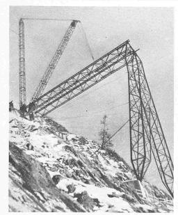
Bild 10. Einsetzen der Montagebühne (linkes Ufer)
