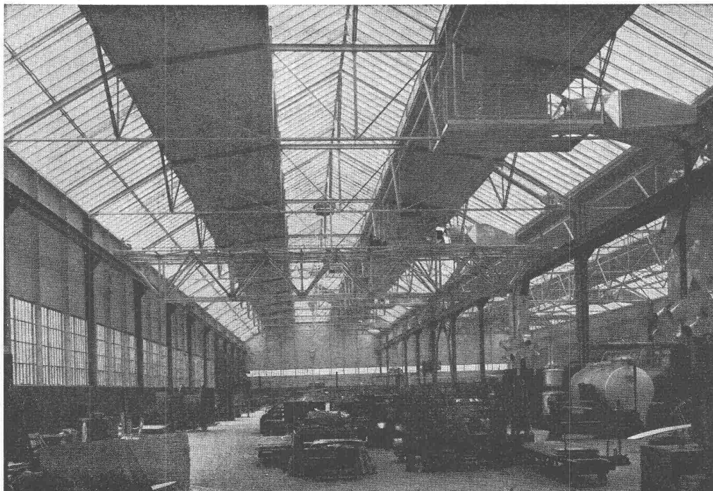
Produktionshalle, Krangerüst in Leichtmetall
