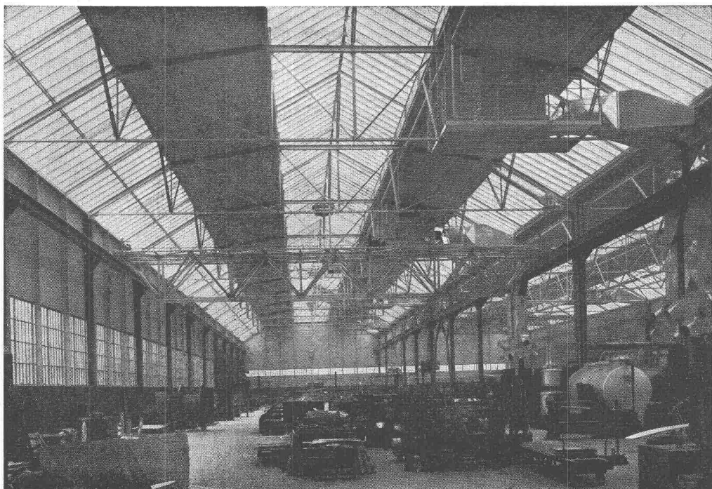
Produktionshalle, Krangerüst in Leichtmetall
