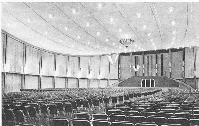
Bild 28. Schwarzwaldhalle in Karlsruhe (Deutschland), 1953. Vorspannte Hängeschale in Sattelform über einer ovalgeformten Grundfläche von 3200 \text{ m}^2 mit 73,50 m Spannweite in der Längsrichtung und 48,60 m in der Querrichtung. Durchhang in der Längsrichtung 4,50 m, in der Querrichtung 1,25 m, Dicke der Schale 5,8 cm bis 7,8 cm bei den Rippen zur Unterbringung der Spannstäbe \phi 26 des Systems Dywidag, Längsspannglieder im Abstand von 40 cm, Querspannglieder in Rippen, Abstand 5,0 m. Entwurf der Tragkonstruktion: Studienbureau Dyckerhoff & Widmann KG. (Dir. Dr. Ing. U. Finsterwalder), München. Ausführung: Arbeitsgemeinschaft Dyckerhoff & Widmann KG., Ways & Freytag AG. und Jordan, Karlsruhe
